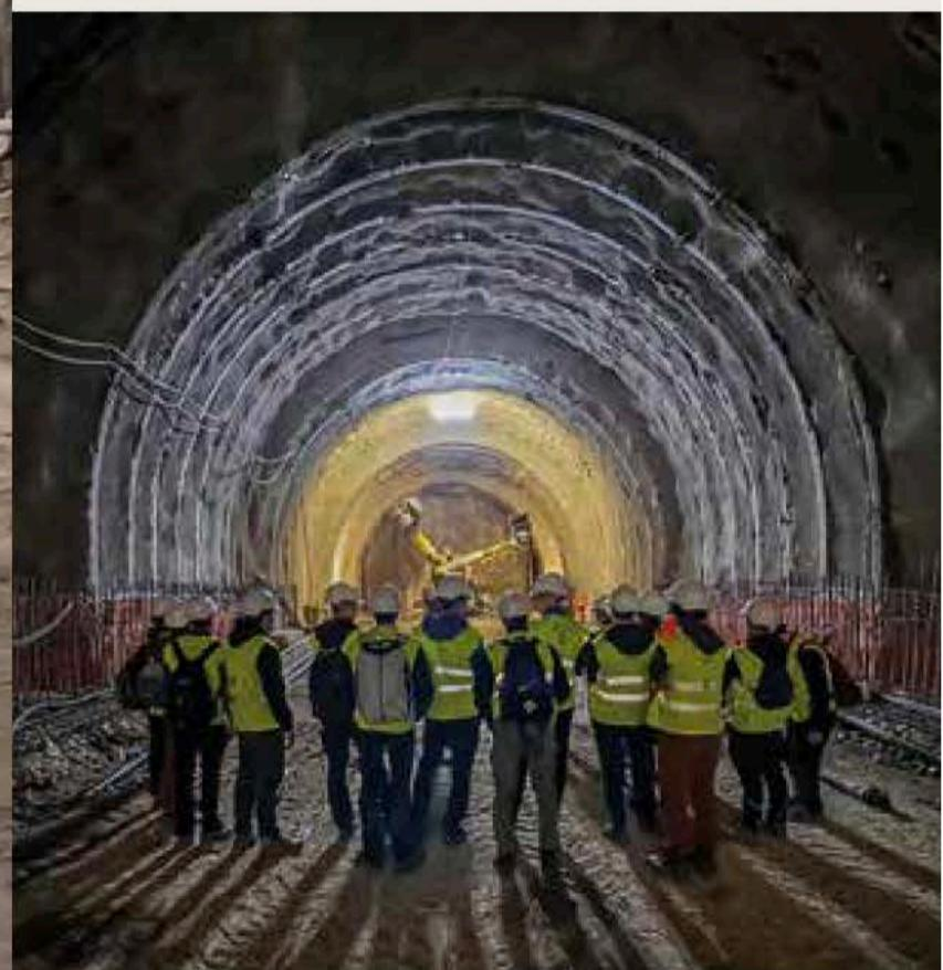
vengono effettuati, lato Merano, da una perforatrice Soilmec ST-120, mentre, dal lato Tirolo/Monte San Zeno, a eseguirli è una perforatrice Soilmec ST-60. Entrambe realizzano consolidamenti in calotta, fronte e piedritti propedeutici allo scavo delle sezioni in avanzamento della galleria in direzione opposta l'una rispetto all'altra.
